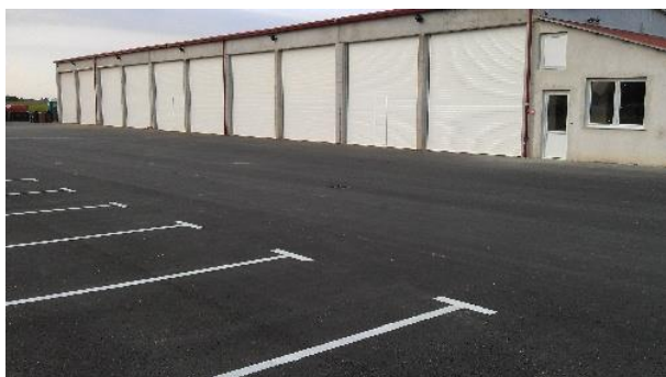
Sl. 16. Garaže u reciklažnom dvorištu
